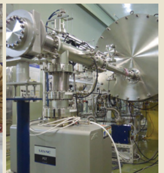
加速器は良質の真空が不可欠 写真はアルバック製イオンポンプ
