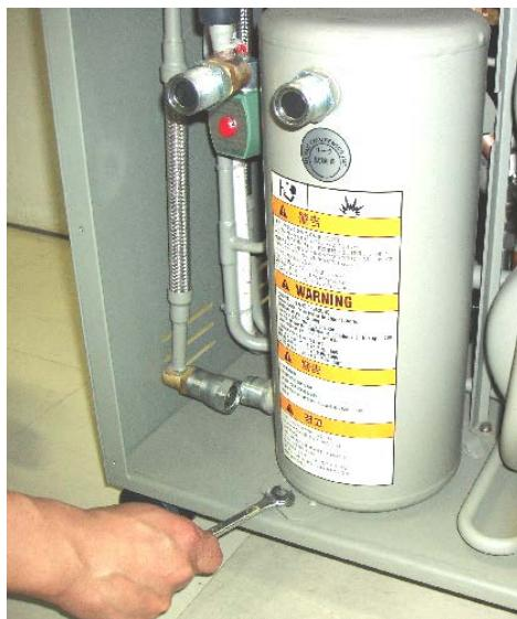
図 7-6 アドソーバ取付けボルトを外す(左)
