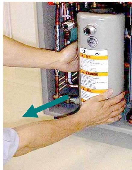
9. 新しいアドソーバを取り付けます。新しいアドソーバのダストキャップ 2 個を取り外します。このアドソーバを筐体底面の押え金具に合わせて奥に入れ込みます。取り付けボルトを仮止めでアドソーバを固定します。
