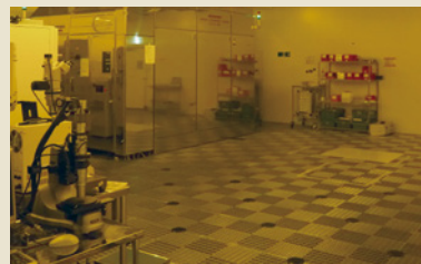
「連邦規格クラス1」スーパークリーンルーム。2014年1月、手前のスペースに新型超高速電子線描画装置F7000S-VD02が導入された。
